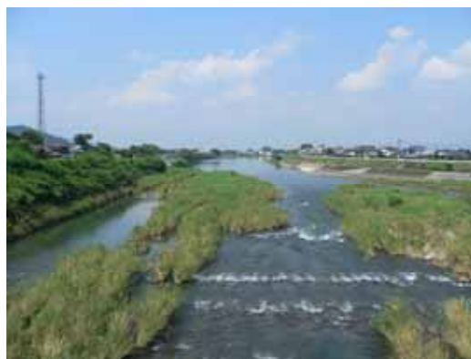
24/800 付近（氾濫原区間） 河床は礫が主となり、平瀬を形成している。 流れは速く川幅は変化に富み細流等がみられる
