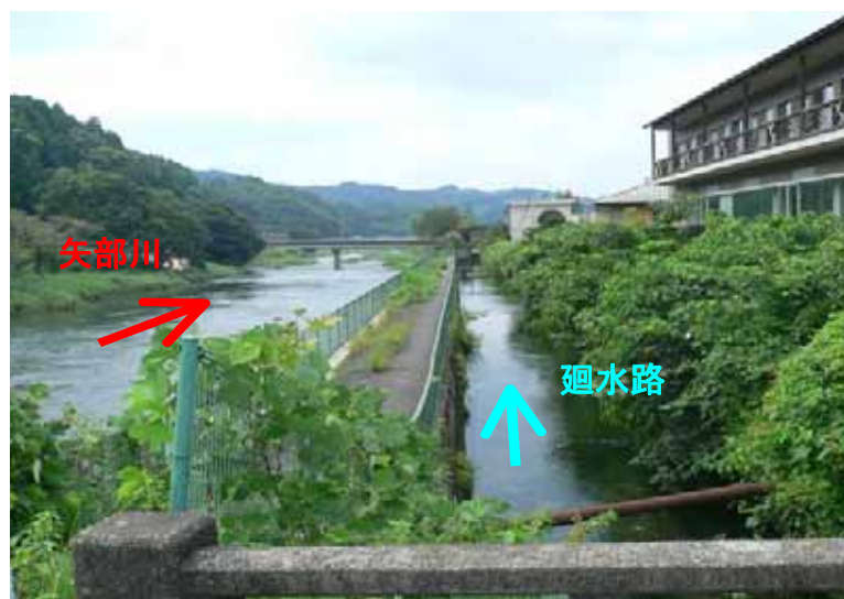
写真-5.1 廻水路の状況（黒木廻水路）
