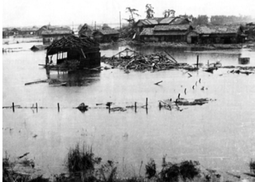
碧南市の被害の様子（昭和34年9月） 矢作川河口部干拓地の被害状況
