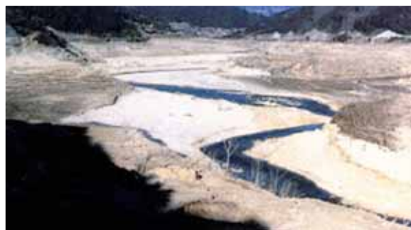
渇水被害の状況 矢作ダム貯水池(平成6年7月)
