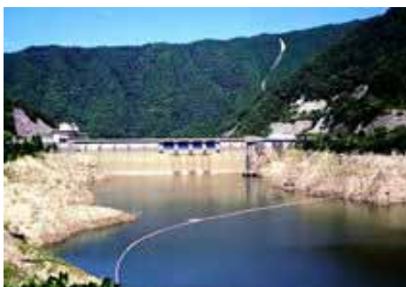
渇水のため水位が下がった矢作ダム (平成6年9月：貯水率17%)
