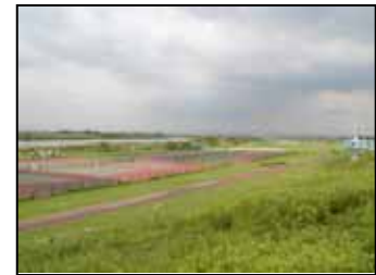
矢作川西尾緑地 愛知県西尾市田貫町他地先 総合的な成績 ( : 四つ星 )
