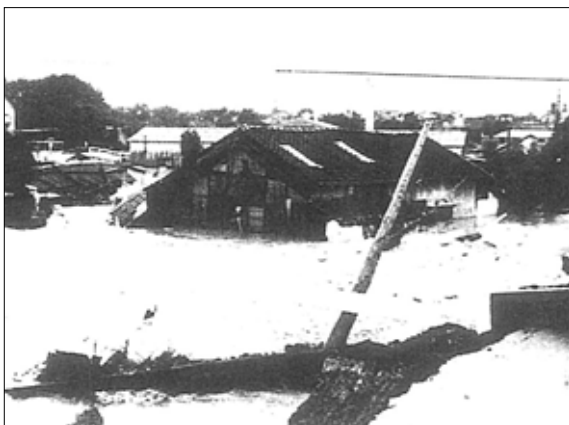
豊田市の被害の様子（昭和47年） 冠水する民家や崩壊した道路 出典：「五十年のあゆみ」
