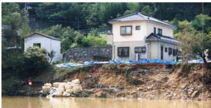
法面崩壊の状況 (右岸 36k+90m 付近 豊田市平和町)
