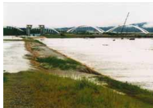
越水の状況 (御立地区付近)
