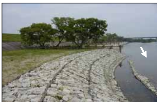
小川護岸(安城市)(H14 年度施工)
