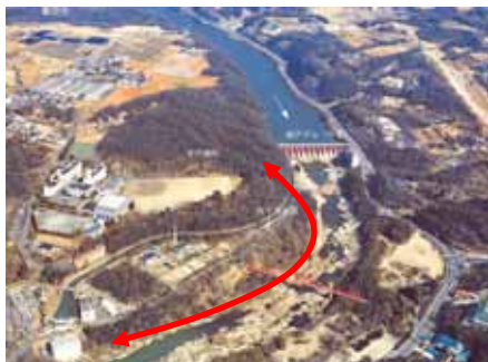
(越戸ダム下流の減水区間)
