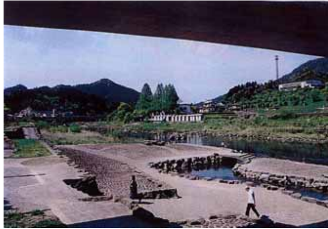
写真 7-4 青地区の高水敷(河口から約 16.4km 地点の右岸) 河川公園として整備され、ボート遊び、水遊び等に広く利用されている。
