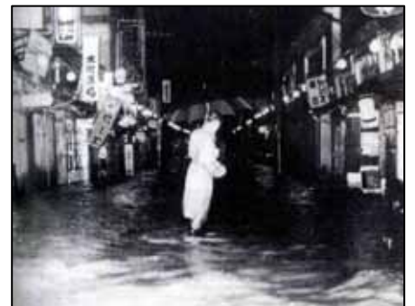
出水状況写真(昭和 19 年 9 月) (出典：大分県災害誌)
