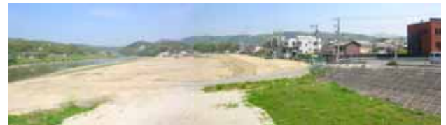
施工後(平成20年撮影)
