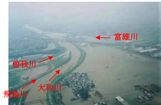
写真 4.13 安堵町・河合町・斑鳩町付近
