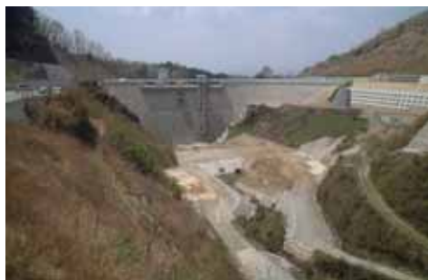
【ダム：岩井川ダム・奈良県】
