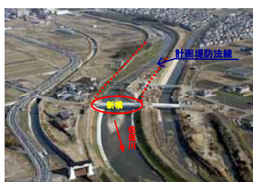
施工後(平成20年撮影)
