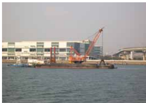
浚渫船による河口部浚渫
