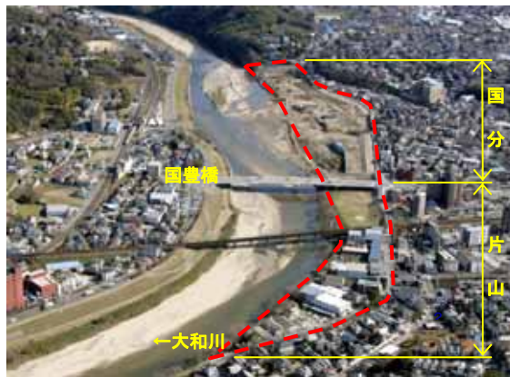
施工後(平成20年撮影)
