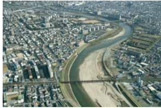
施工後(平成19年撮影)
