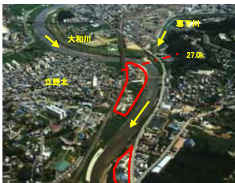
施工前(昭和58年8月撮影)
