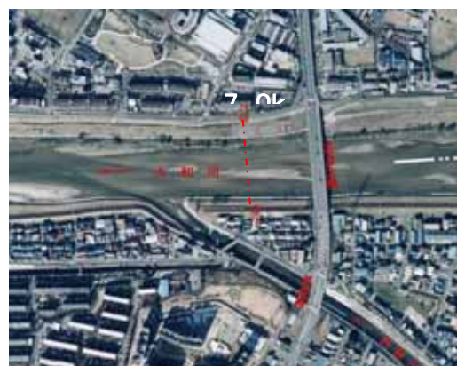
施工後(平成13年12月撮影)
