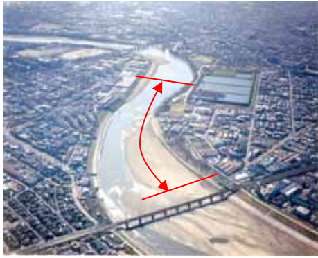
施工前(昭和62年撮影)
