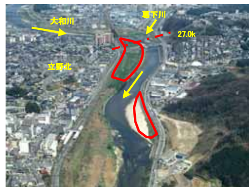
施工後(平成14年3月撮影)
