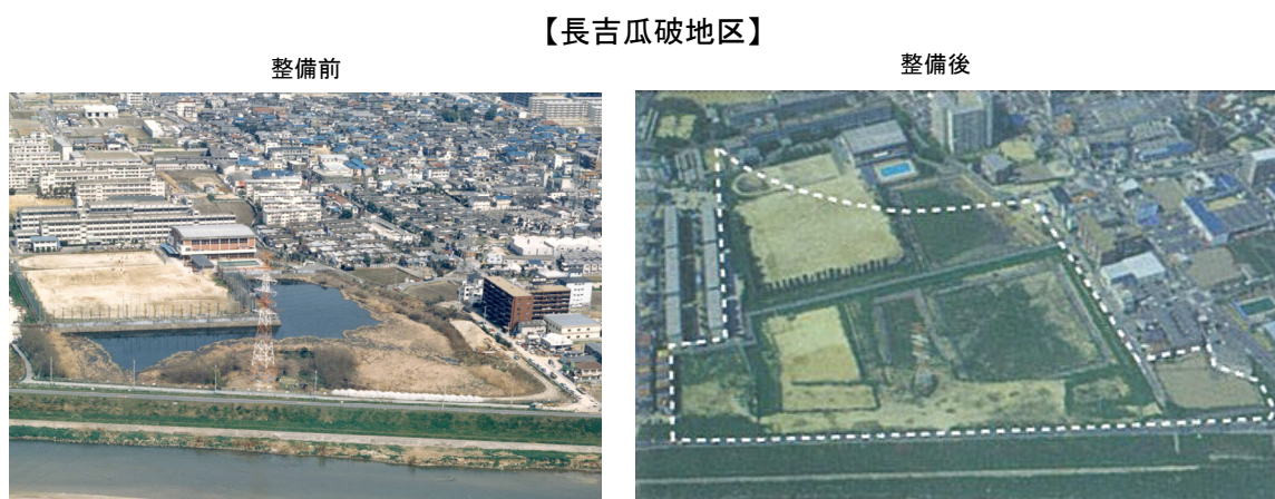
写真4.19 スーパー堤防整備実施箇所
