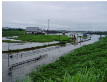
写真 4.15 曽我川保田浄化施設付近
