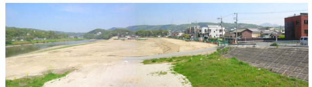
施工後(平成20年撮影)
