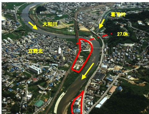
施工前(昭和58年8月撮影)
