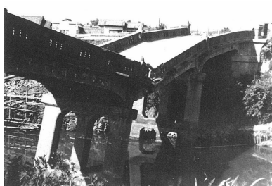
写真 4.6 大和郡山市板東付近
