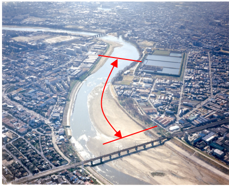
施工前(昭和62年撮影)
