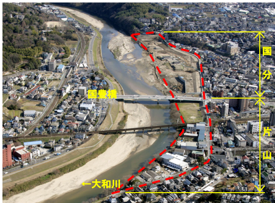
施工後(平成20年撮影)
