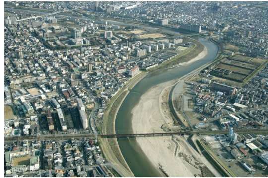
施工後(平成19年撮影)
