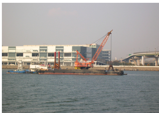
浚渫船による河口部浚渫
