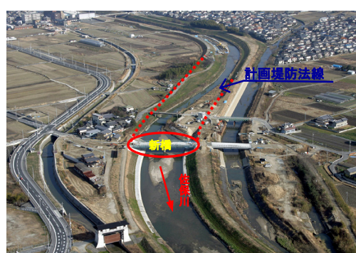
施工後(平成20年撮影)
