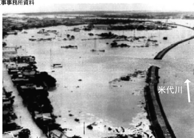
昭和47年7月洪水による被害状況
