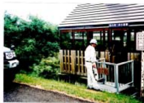
【河川巡視状況（排水樋管の点検）】
