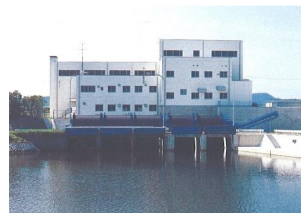
千田川排水機場
