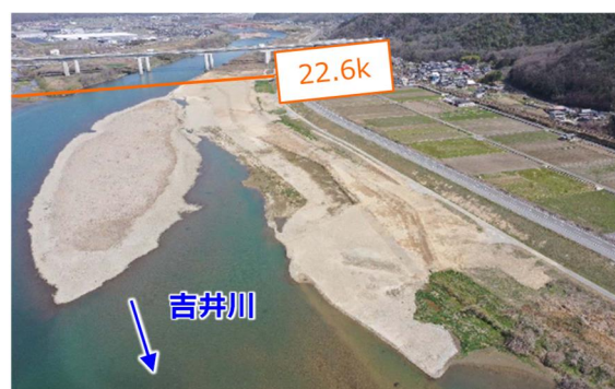
河川改修後（千駄地先 撮影日：令和 3 年(2021 年)3 月
