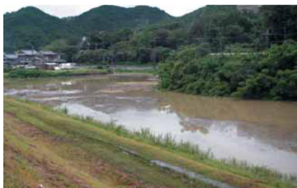
赤磐市熊山地区の内水による浸水
