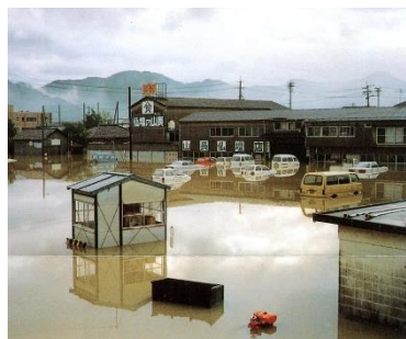
和気町金剛橋右岸の浸水状況
