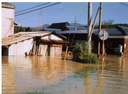
瀬戸内市長船町の浸水状況
