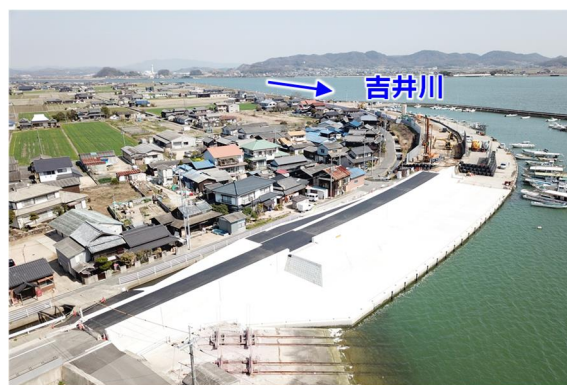
河川改修後（九幡地先 撮影日：令和3年(2021年)3月）
