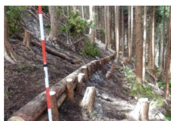
丸太筋工の完了状況
