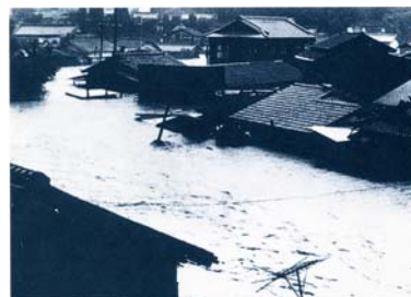
備前市の浸水状況
