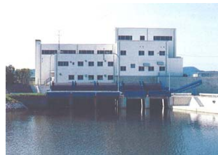
干田川排水機場
