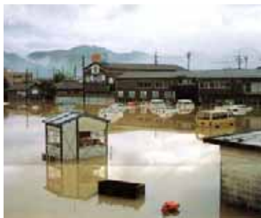
和気町金剛橋右岸の浸水状況
