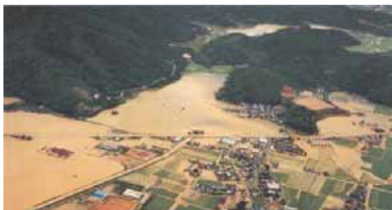
瀬戸内市長船町の浸水状況
