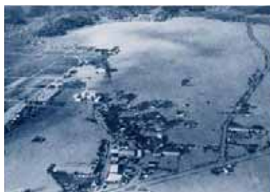
瀬戸内市長船町の浸水状況
