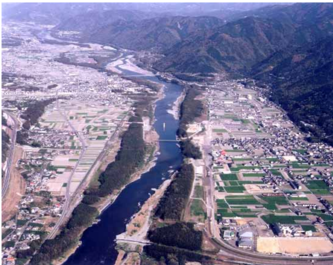
図－1.2(2) 吉野川中流域（ たち の太刀野・加茂第一箇所64km付近）
