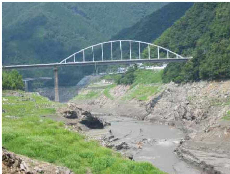
図－5.5(2) 平成17年渇水時の様子（大川橋付近）
