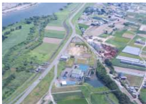
図－9.6 防災ステーション
