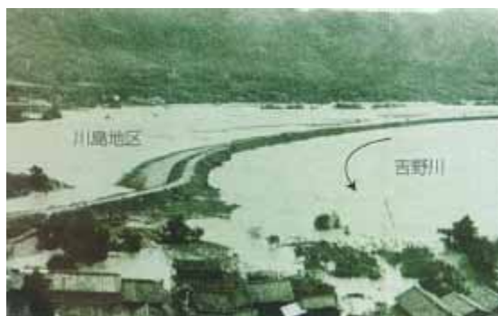
昭和36年洪水時の内水被害状況 (外水位が高い様子がうかがえる)
