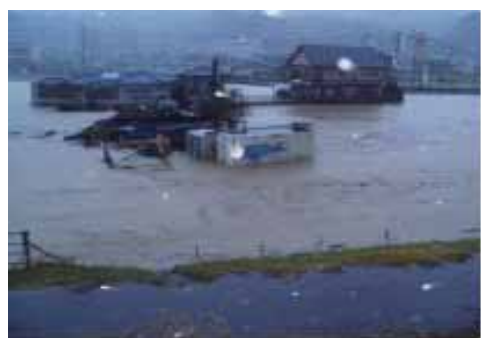
美馬市脇町の内水氾濫（新町谷樋門付近）
