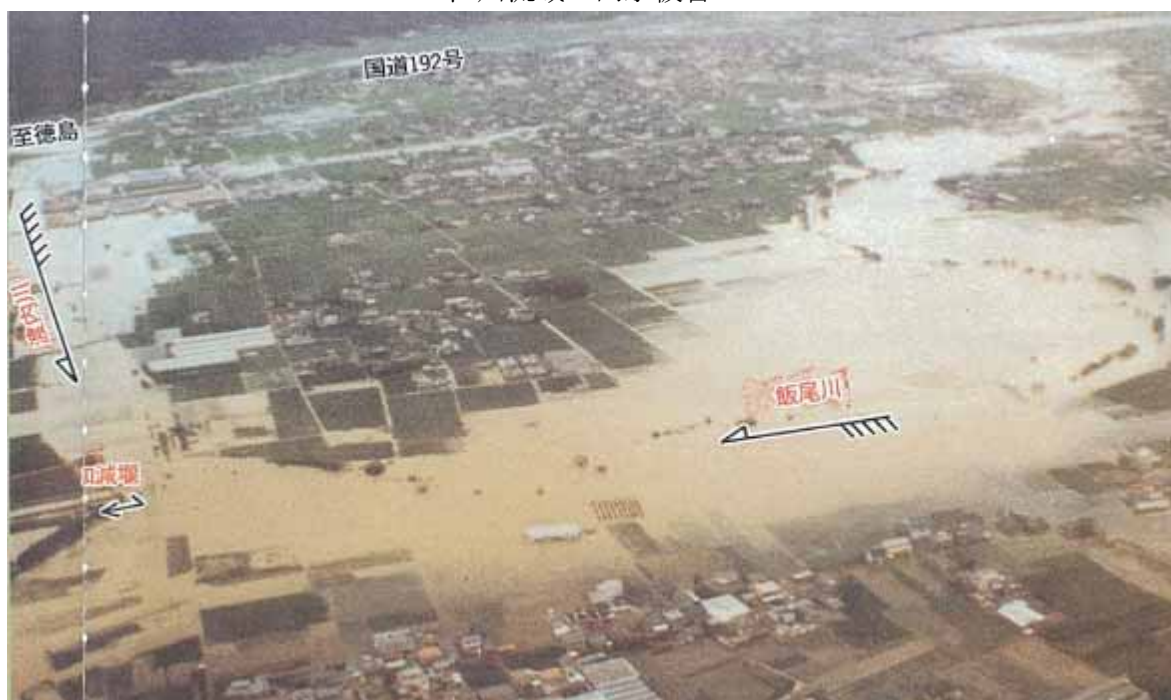
飯尾川流域の浸水状況
