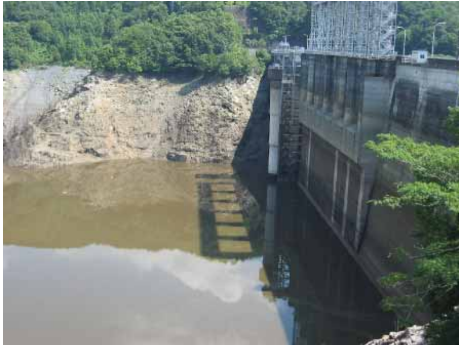
図－5.5(1) 平成 17 年渇水時の様子（早明浦ダム上流）
