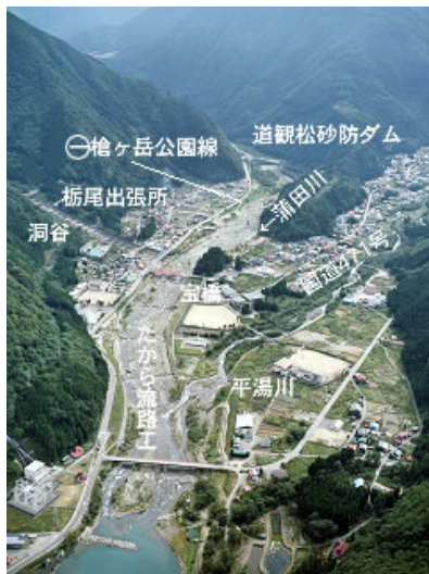
写真④ たから流路工
