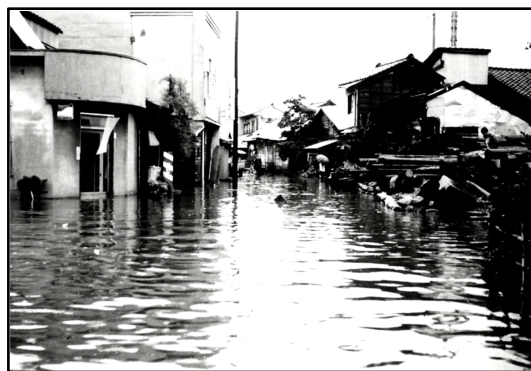
富山市浸水状況
