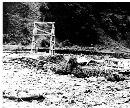
平湯川村上橋流失
