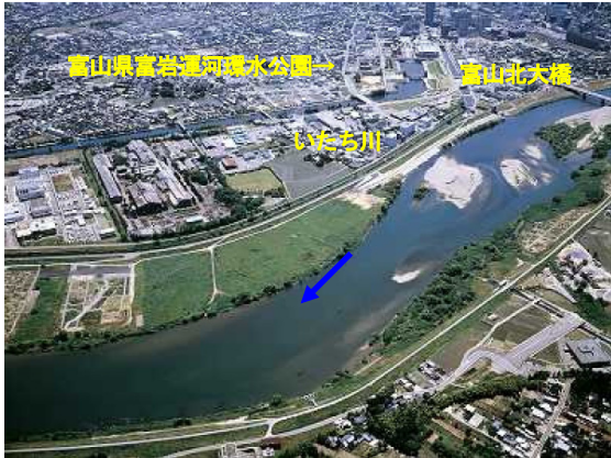
写真④ 神通川 5.0k 富山北大橋下流から上流を望む
