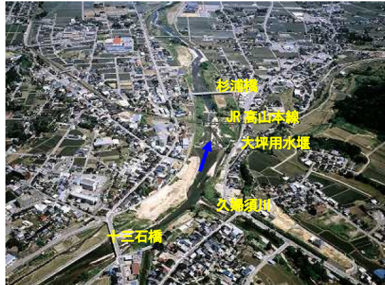
写真⑯ 井田川 14. 8k 十三石橋上流から下流を望む
