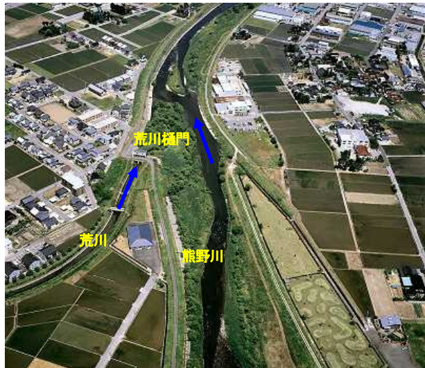
写真⑧ 荒川樋門付近
