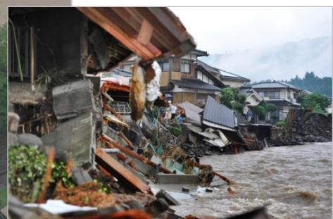
河岸侵食による家屋の流失 〔写真提供 西日本新聞社〕
