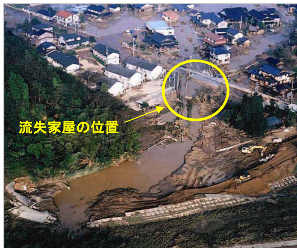
堤防決壊に伴う氾濫流により 木造家屋が倒壊した状況
