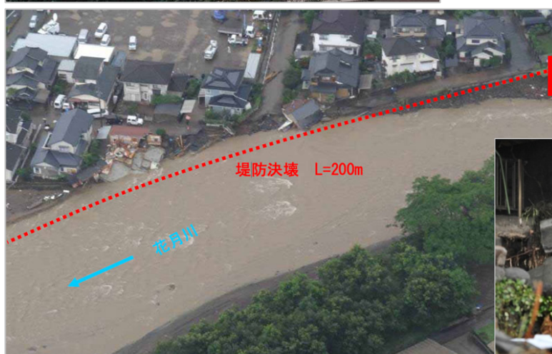
河岸侵食により家屋倒壊した状況
