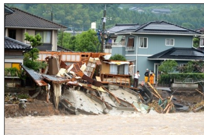
河岸侵食による家屋の流失（朝日新聞社提供）
