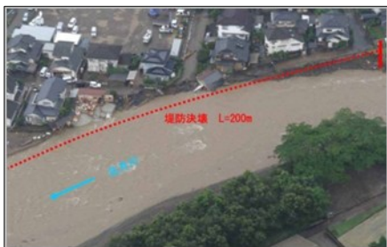
侵食により家屋が流失した状況
