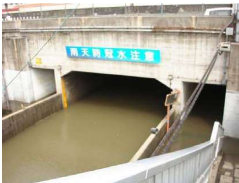
図 3-7 アンダーパス冠水の事例
