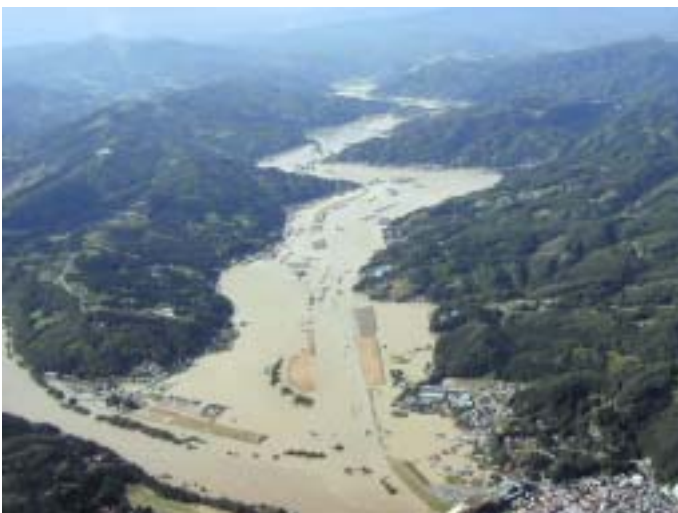
【平成14年台風6号による被害を受けた砂鉄川】 (岩手県：平成14年7月)
