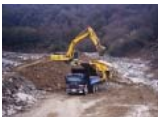
発生土の運搬
