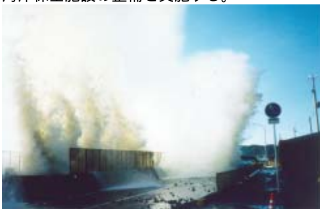
【越波により寸断される重要交通網 （国道42号、和歌山県）】
