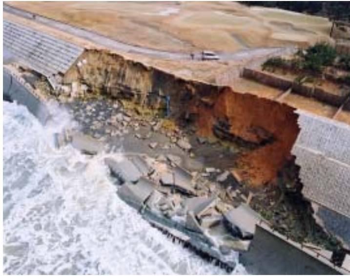
【冬季風浪による堤防崩壊（小松海岸 平成 12 年 1 月）】
