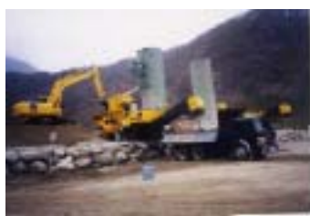
発生土とセメントの混合
