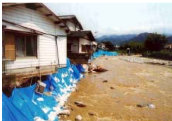
【梅雨前線豪雨による被災状況 ：椎原川(福岡県福岡市早良区、平成15年7月)】
