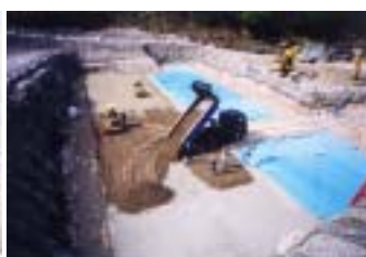
ソイルセメント敷均し・締め固め
