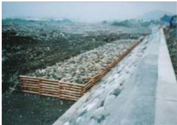
【間伐材を活用した根固工(木工沈床工)(酒匂川(神奈川県))】
