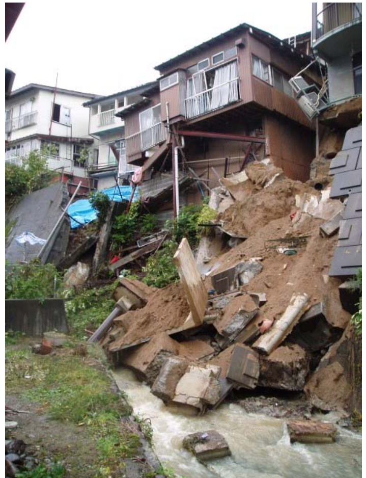
【護岸の崩壊により流れそうになっている家屋 （新潟県小千谷市（湯殿川））】
