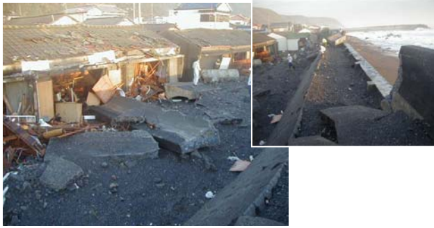
【高知県菜生海岸の被災状況】
