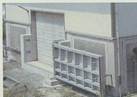
耐水扉の設置
