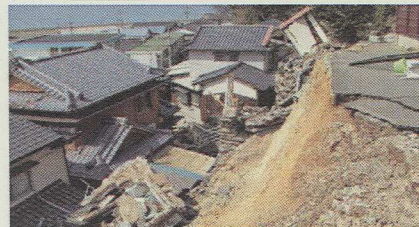
地震による斜面崩壊 平成17年福岡県西方沖地震（玄界島）
