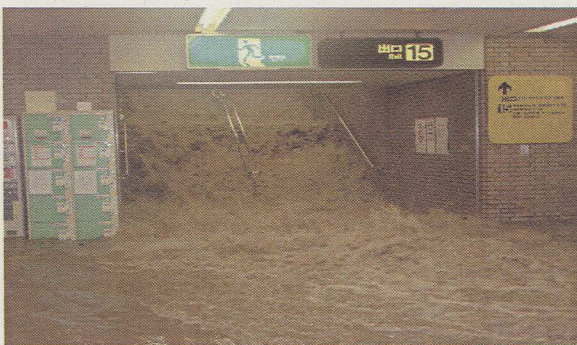
H15.7 地下施設浸水（福岡市）
