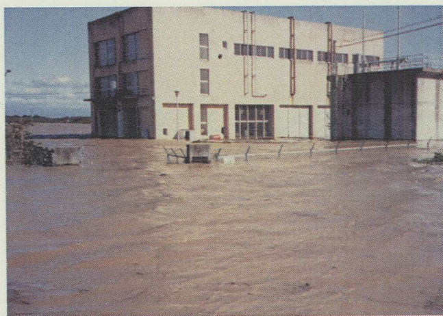
浸水した排水ポンプ場
