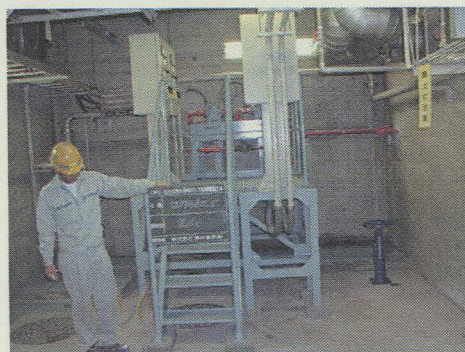
機側操作盤の嵩上げ
