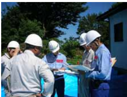
災害緊急調査の状況
