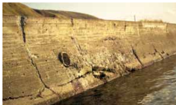
堤防の表法被覆工が損傷
