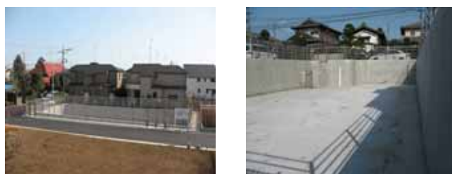
雨水貯留浸透施設の例
