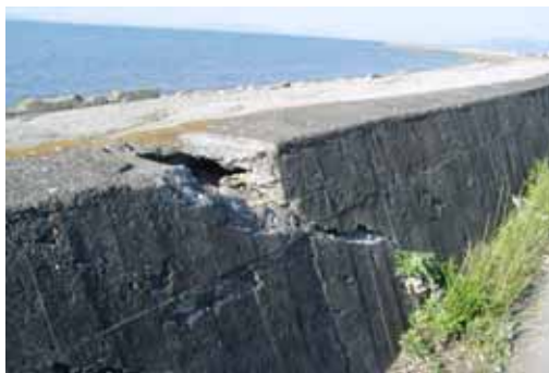
堤防の波返工が損傷
