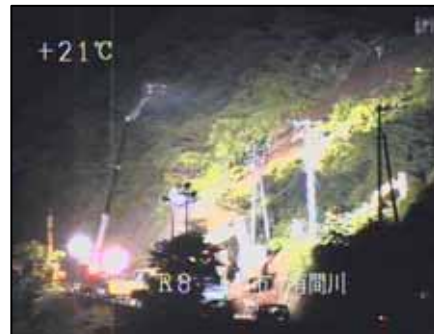
国道8号上越有間川の法面崩壊現場
