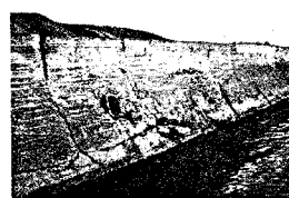
堤防の表法被覆工 が損傷
