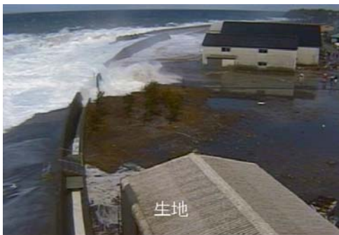
激しい高波により越波が発生 (黒部市生地地先)
