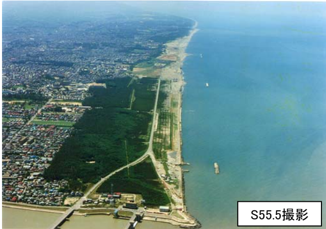
整備着手直後の侵食状況
