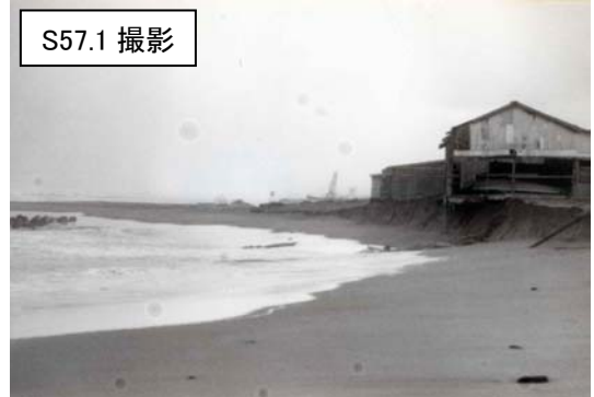
冬期風浪により船小屋基礎部まで砂浜が流失(有明浜工区)
