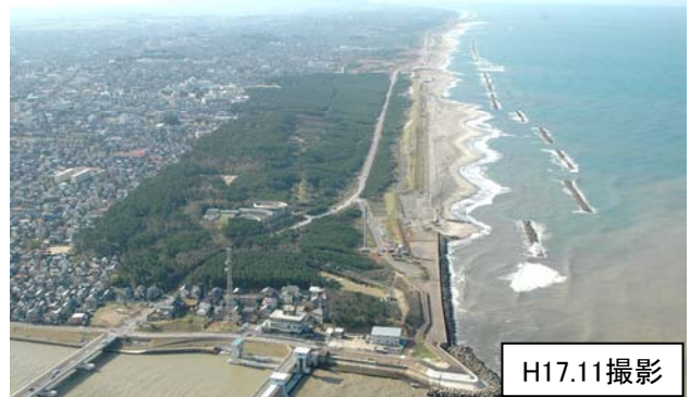
整備後の砂浜回復状況
