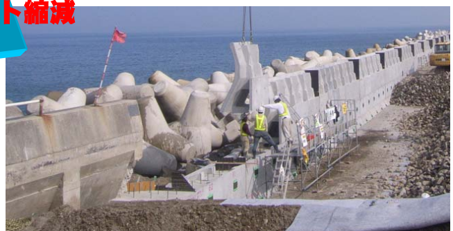
プレキャスト部材 設置状況
