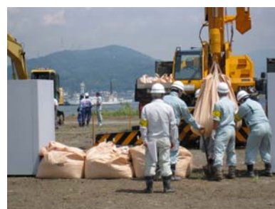
堤防応急復旧訓練
