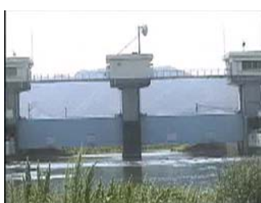
水門・陸閘閉鎖訓練
