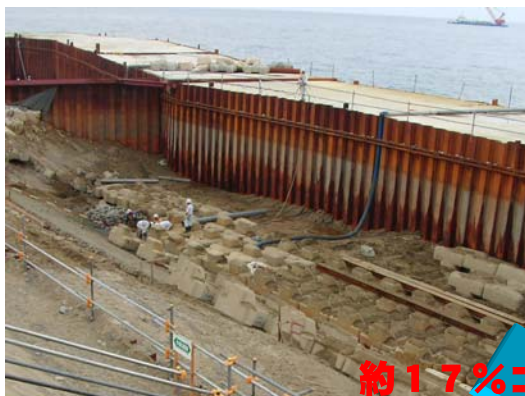
大規模な仮締切による施工
