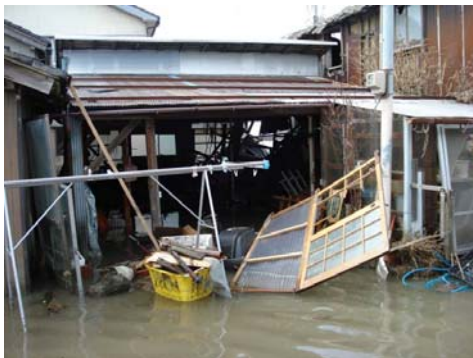
激しい越波により背後の住宅等が浸水
