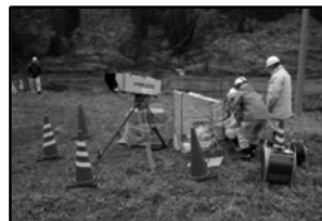
監視カメラ(6 台)を用いて被災箇所の 24 時間監視を実施
