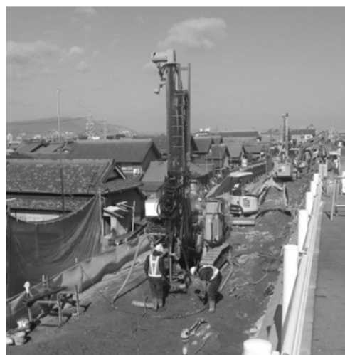
締固め工法による液状化対策（三重県桑名市）
