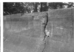
鋼矢板の腐食・コンクリートの劣化、堤防のひび割れ
