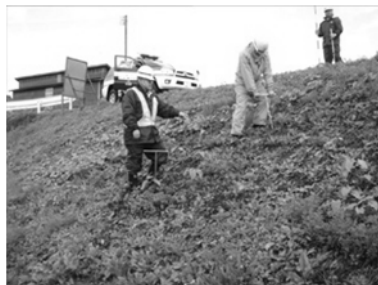
堤防点検状況
