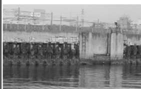
鋼矢板の腐食・コンクリートの劣化、堤防のひび割れ
