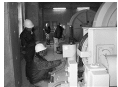
ダム放流設備点検状況
