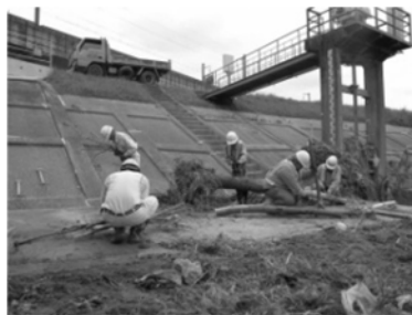
樋門吐口に堆積した塵芥の処理
