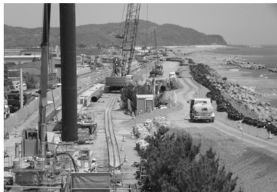
海岸堤防の耐震・液状化対策（高知県土佐市）
