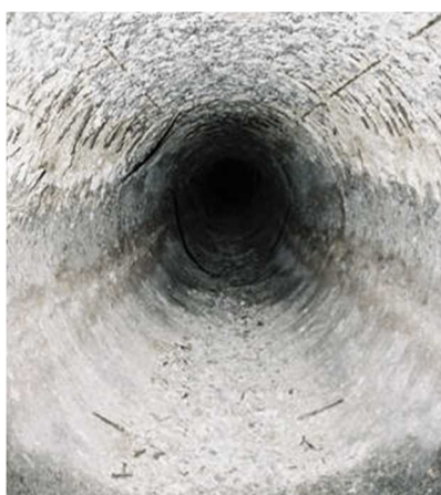
硫化水素で腐食した管渠
