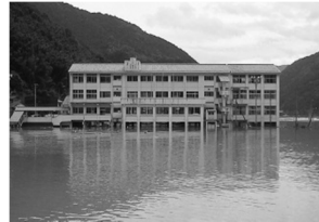
H26.8 避難所 2 階の浸水 (徳島県阿南市)
