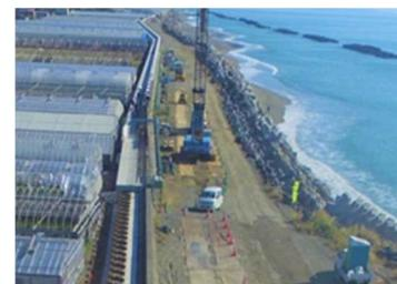
陸閘の閉塞(高知県高知市) 海岸堤防の耐震化(高知県南国市)
