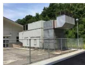
②高所等の点検
