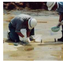
クラック補修状況（注工）
