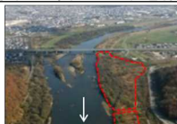
・河道掘削や樹木伐採
