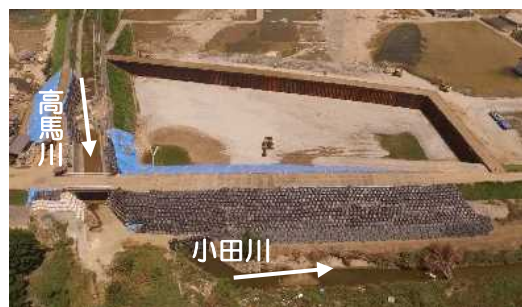
堤防復旧状況（7/21 10:00 時点）左岸 3k400 （小田川と高馬川の合流点）
