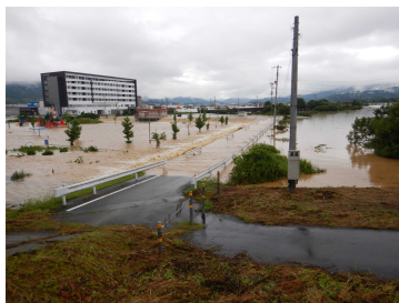
ひじがわ 肱川沿川の被災状況（ あきすし 愛媛県大洲市）
