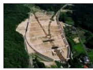
・遊砂地等の整備
