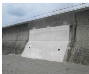
陸間の閉塞(高知県高知市) 海岸堤防の耐震化(高知県南国市)
