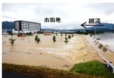
越水による浸水被害 愛媛県大洲市
