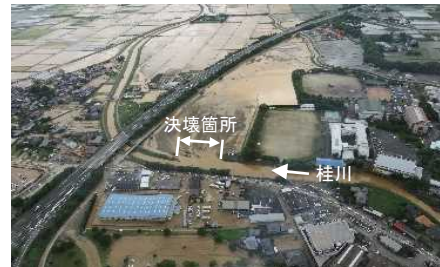
桂川沿川の浸水被害（ あきくらし 福岡県朝倉市）
