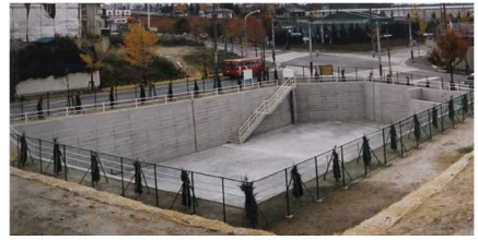
小規模な雨水貯留浸透施設の例
