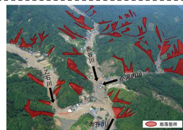
山腹崩壊と土砂流出の状況（赤谷川）
