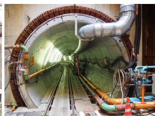
雨水貯留管の整備
