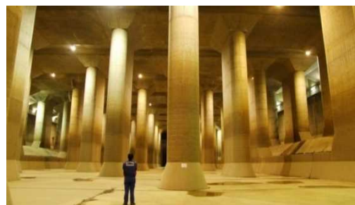
首都圏外郭放水路（埼玉県）
