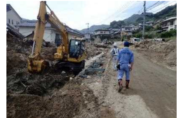
河道閉塞箇所における土砂等の撤去作業 (広島県坂町)
