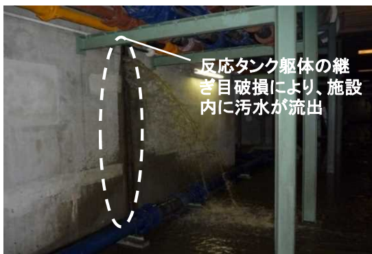
処理場の被災事例(漏水)
