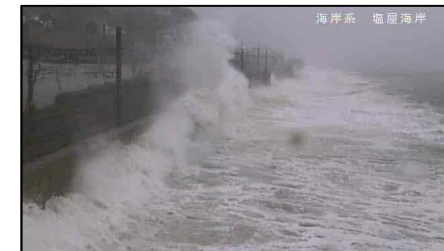
平成30年台風第21号 垂水工区
