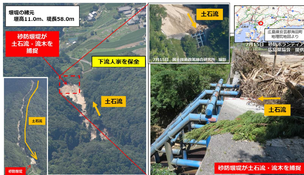
あきぐんかいだちょうみさこがわ 土石流捕捉事例(広島県安芸郡海田町三迫川)
