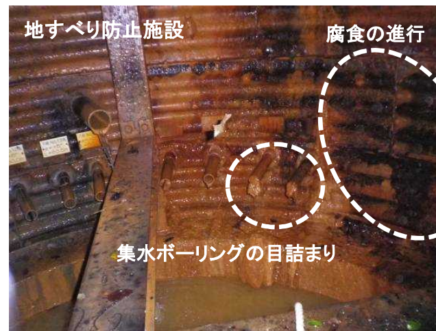
排水機能の低下・集水井の主要部材の腐食
