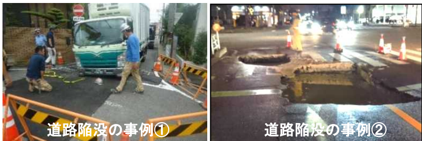
管路施設に起因した陥没事故は年間約3,000件発生
