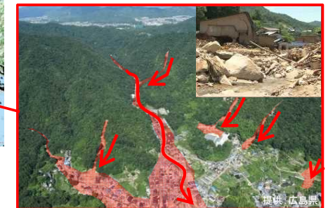
土砂・洪水氾濫発生状況
