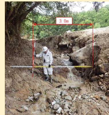
砂防事業における現地調査
