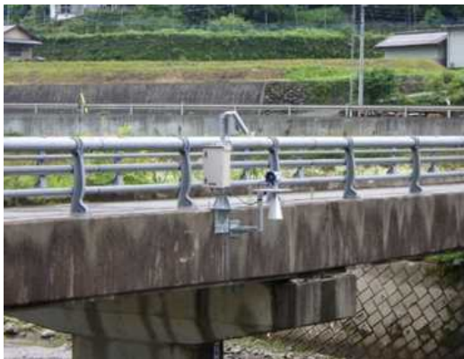
中小河川等の水位観測の充実 (危機管理型水位計の設置)
