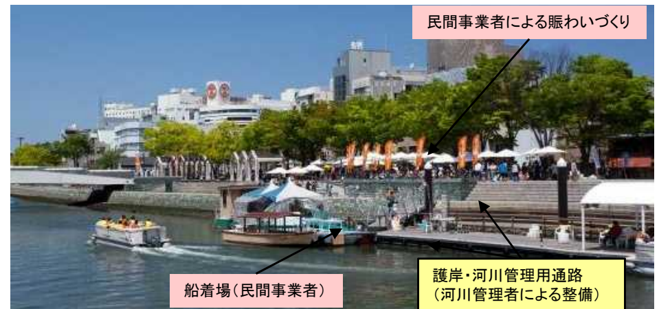
民間事業者による船着場の整備に併せ、河川管理者が親水護岸等を整備
