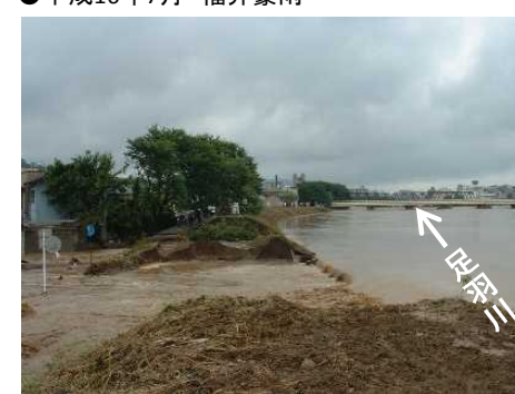
堤防の決壊状況(福井市春日)
