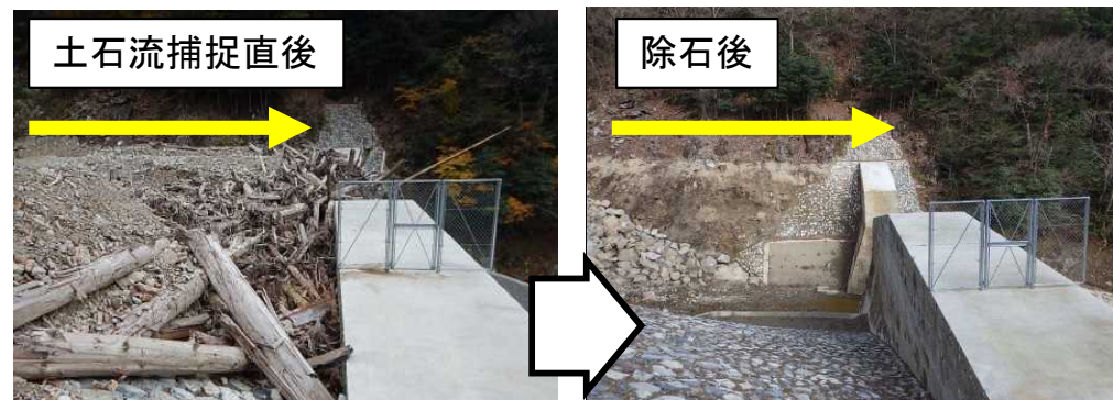
砂防堰堤の除石事例
