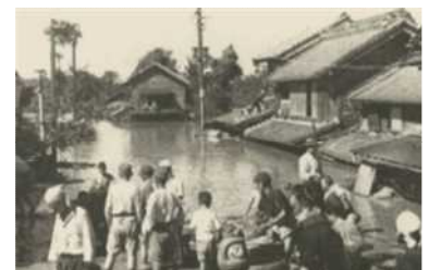
氾濫状況(埼玉県久喜市)
