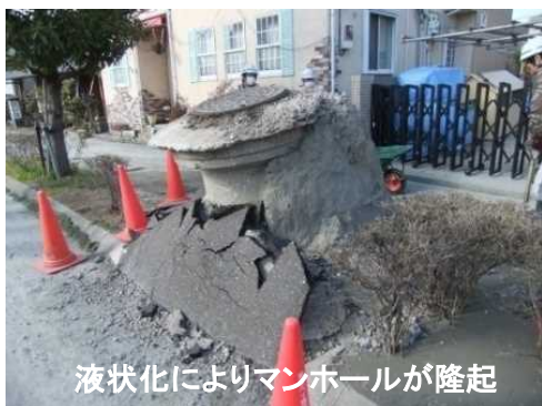
管路の被災事例
