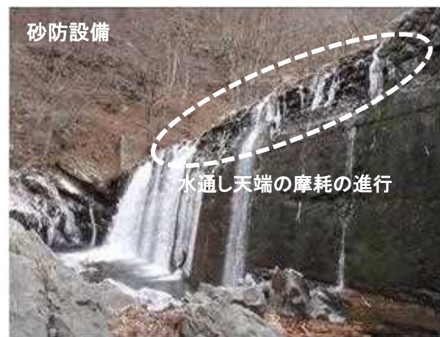
砂防堰堤の天端摩耗による堰堤の土砂捕捉機能低下
