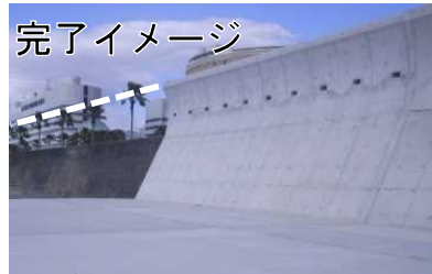
堤防のかさ上げ（千葉県浦安海岸）
