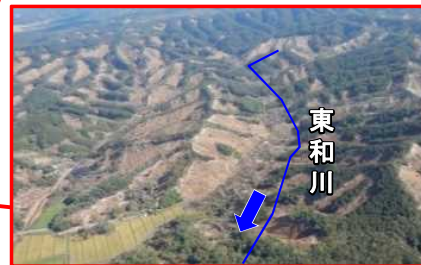
山腹崩壊発生状況
