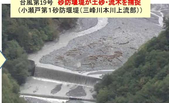
台風第19号 砂防堰堤が土砂・流木を捕捉(小瀬戸第1砂防堰堤(三峰川本川上流部))
