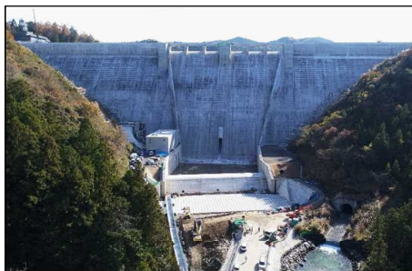
かわかみ 川上ダム建設事業
