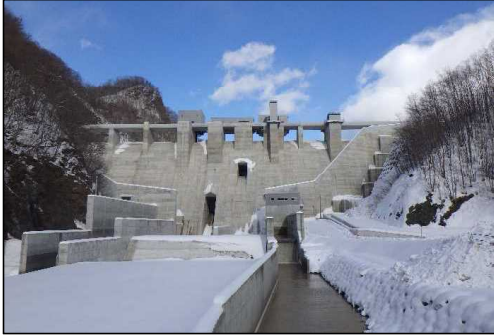
さるがわ 沙流川総合開発事業(平取ダム)
