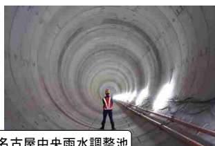
建設中の名古屋中央雨水調整池
