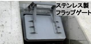
水位変動で開閉する無動力化、
