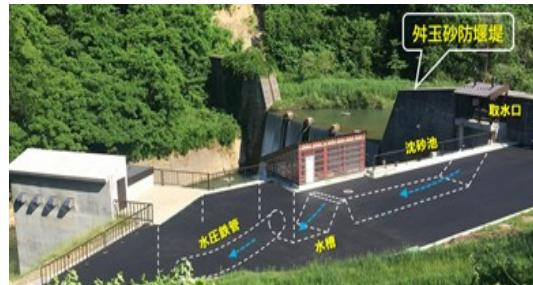
砂防堰堤への小水力発電導入事例
