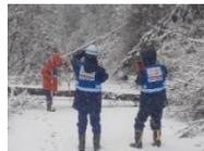
ポールや巻尺などにより、計測した被害箇所をスケッチや図形描画により作成。数量は現地計測値より都度計算している。
