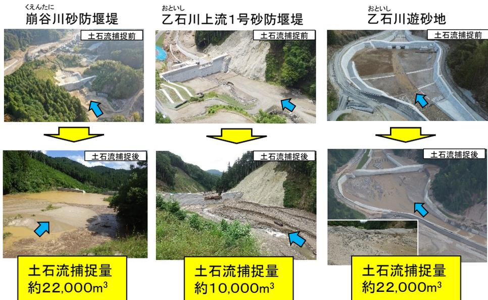
※計19箇所の砂防堰堤等で土石流を捕捉 ⇒ 総捕捉量推計約10万m<sup>3</sup>
