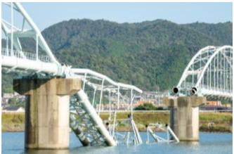
和歌山市水管橋の落橋による断水(R3.10)
