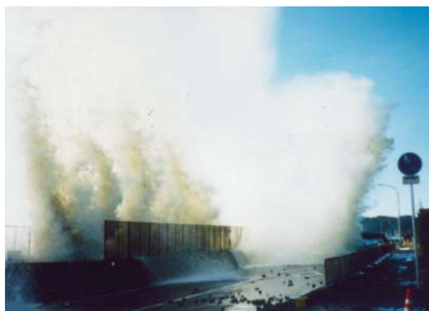
波により寸断される重要交通網 平成9年 (和歌山県 古座町 古座海岸、国道42号)
