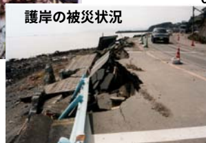
護岸の被災状況
