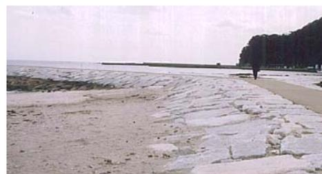
砂浜端部に滑らかな収束感を与える突堤の例
