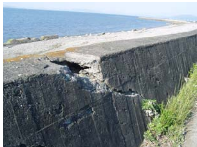
堤防の波返工が損傷
