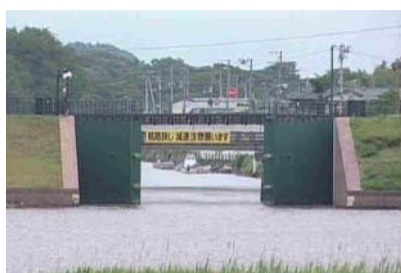
水門・陸間閉鎖訓練
