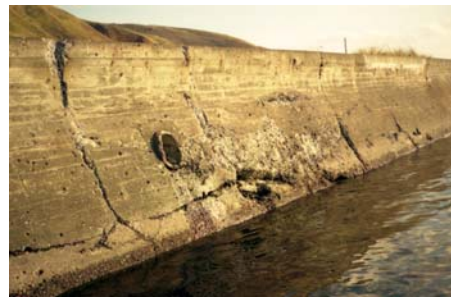
堤防の表法被覆工が損傷
