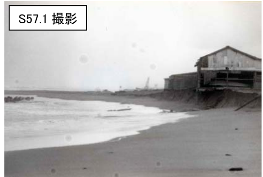
冬期風浪により船小屋基礎部まで砂浜が流失(有明浜工区)
