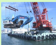
大規模津波防災訓練での 起重機船によるバックホウ陸揚げ
