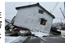
能登半島地震での木造住宅の被害
