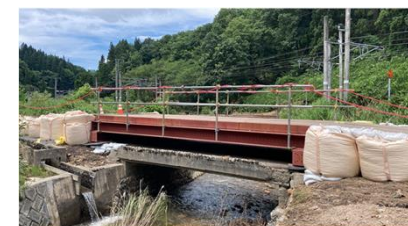
早期復旧に繋がった仮設橋設置状況
