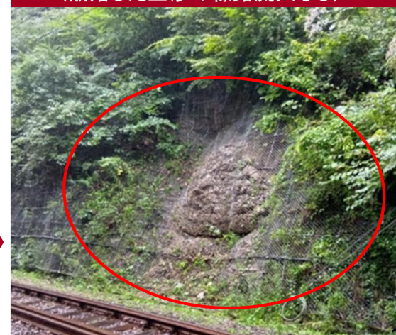
令和6年台風第10号では被害を防止 （崩落した土砂の線路流入なし）
