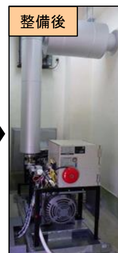
非常用電源設備の換装
