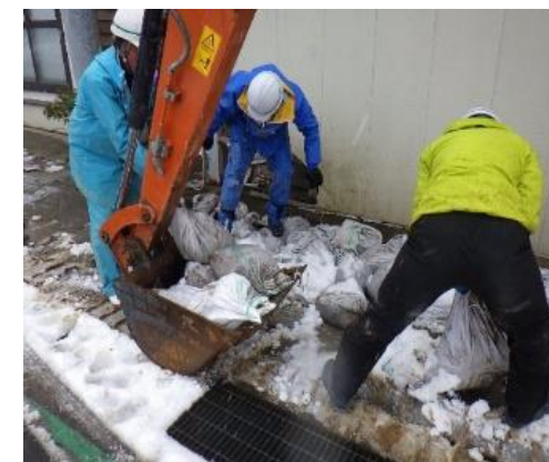
工事業者による土砂回収状況
