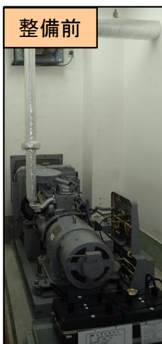
非常用電源設備の換装
