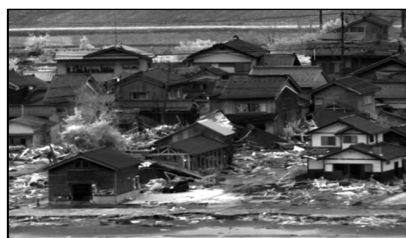
無操縦者航空機による被害状況調査
