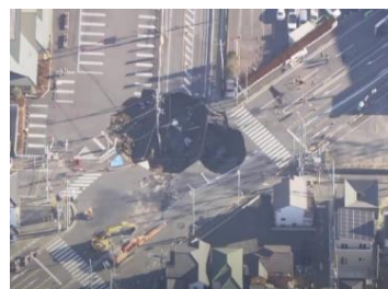
1月31日時点の 事故現場の状況
