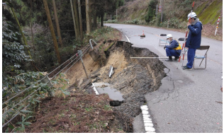
危険な箇所での被災状況調査（石川県志賀町）
