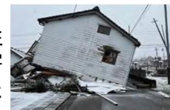
能登半島地震での 木造住宅の被害
