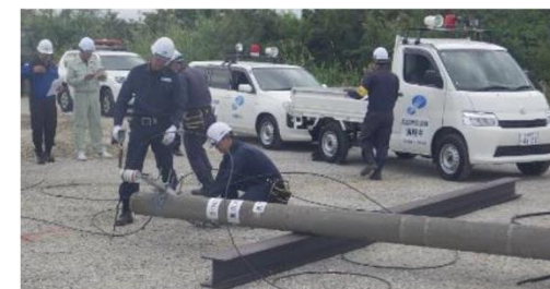
電力事業者による倒壊電柱の除去訓練
