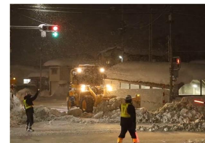
スクラム除雪実施状況(青森県弘前市)
