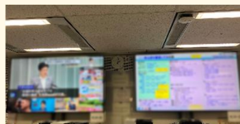
防災センターにおける映像表示設備の大型化(情報を円滑に共有することで初動対応を迅速化)
