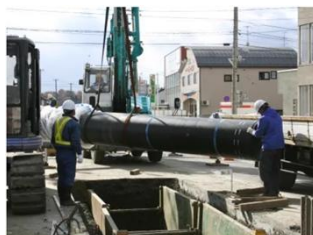
耐震管の布設工事
