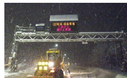
直轄国道の除雪状況(国道49号)
