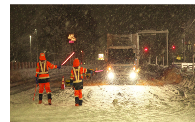
直轄国道の集中除雪状況(国道8号)
