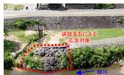
一部崩壊した水製の応急対策状況
