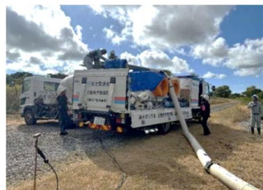
TEC-FORCE等による排水ポンプ車等を活用した給水(新潟県村上市)
