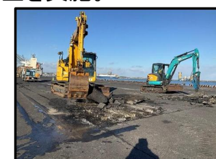
応急復旧工事施工状況
