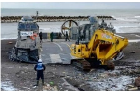
自衛隊と連携した海路を活用した道路啓開用重機の運搬
