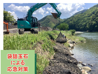
応急対策の実施状況
