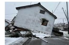
能登半島地震での木造住宅の被害
