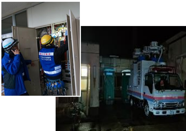
電源供給により停電解消
