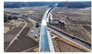
首都圏3環状道路の機能確保 首都圏中央連絡自動車道（大栄～横芝：R6年度開通予定）
