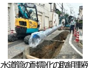
水道管の耐震化の取組事例
